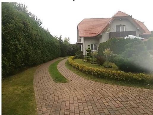
WIDOK OD STRONY PŁN.-WSCHODNIEJ
